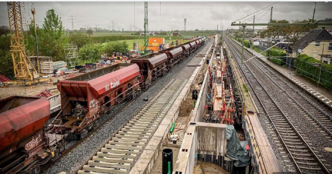
Blick Richtung Norden
