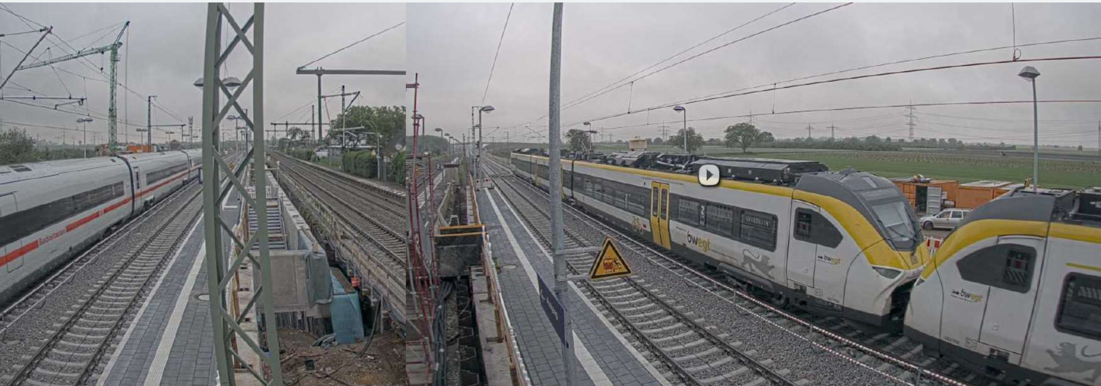
Blick Richtung Norden
